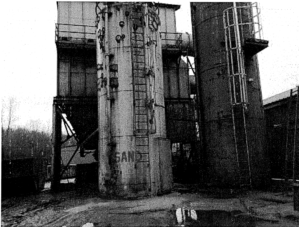
Image 7(Sand silos) : Sand silos
