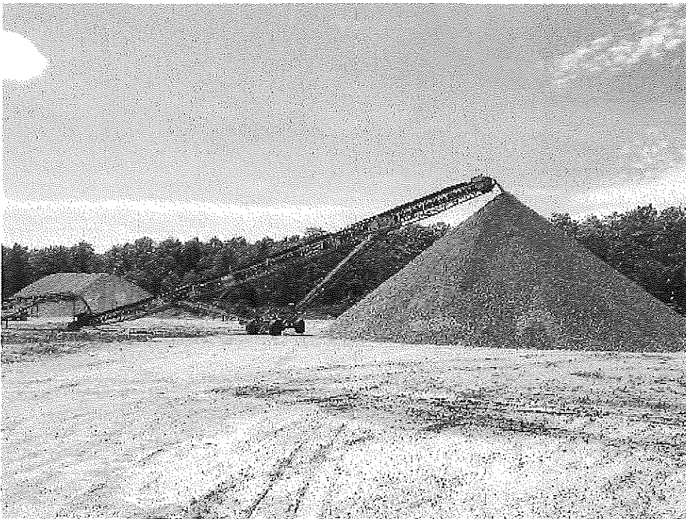
Image 1(NS1) : Radial stacker conveyor EU_14
